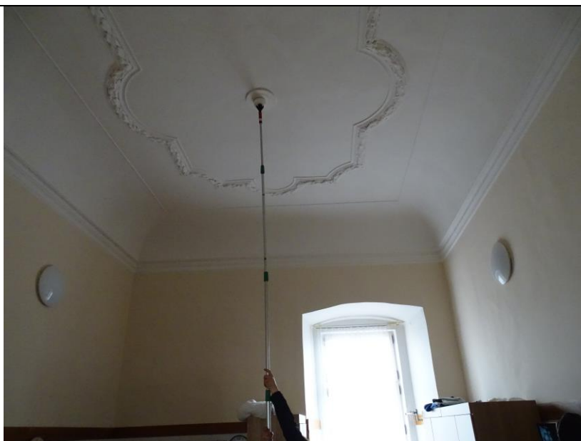
Obr. P1-6 — umístění opticko-kouřových hlásičů v pokoji 2.NP
