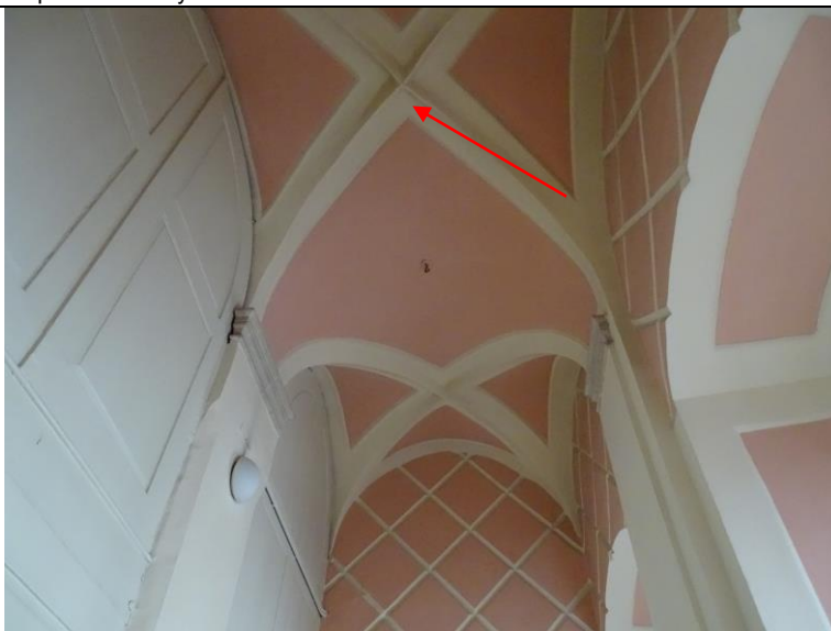
Obr. P1-5 — umístění opticko-kouřových hlásičů v chodbičce 2.NP
