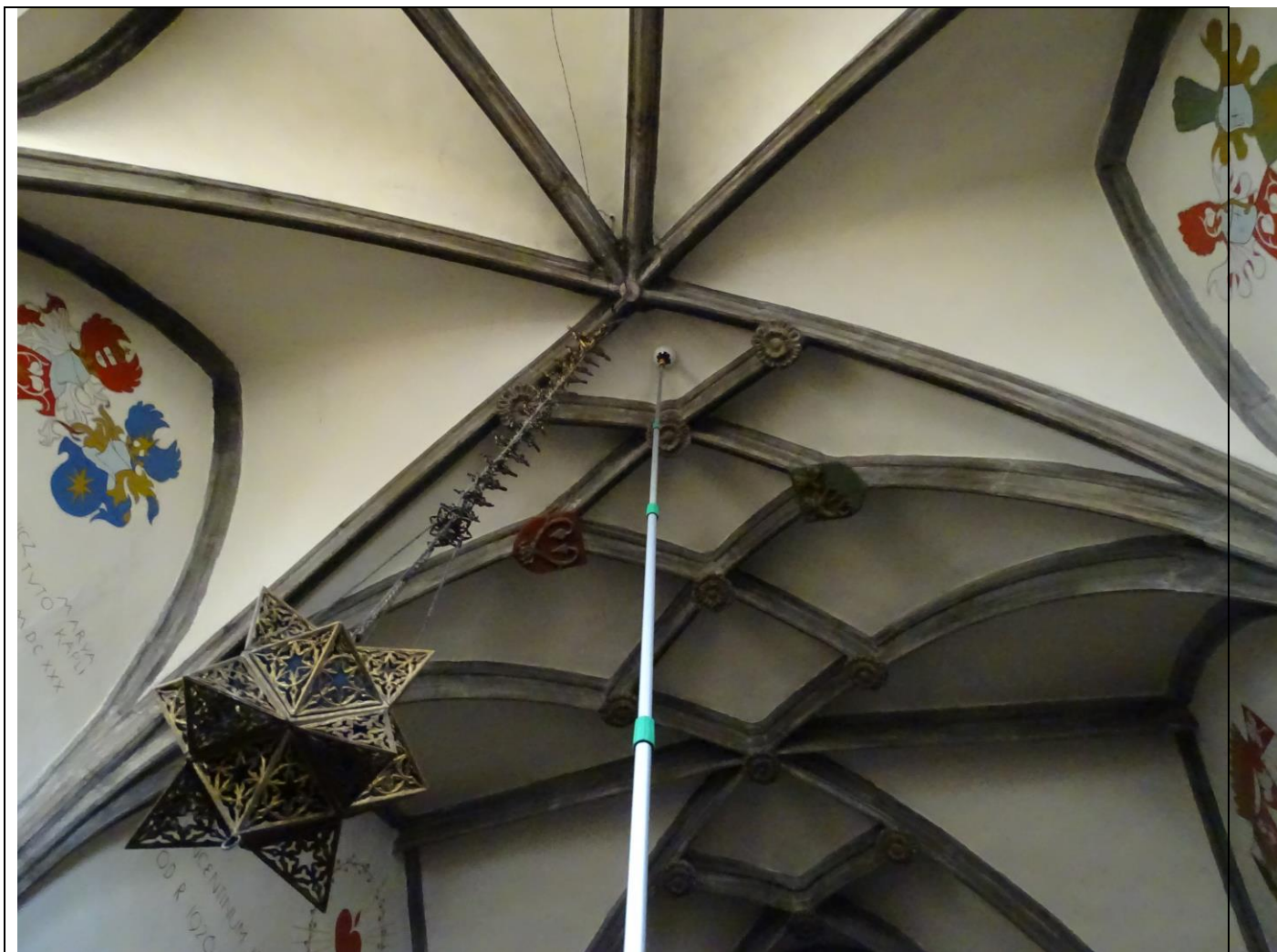
Obr. P1-1 — umístění hlásiče opticko-kouřového v kapli
