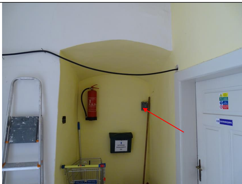
Obr. P1-8 – umístění ústředny, zakrytí výklenku požárním předělem s dvířky
